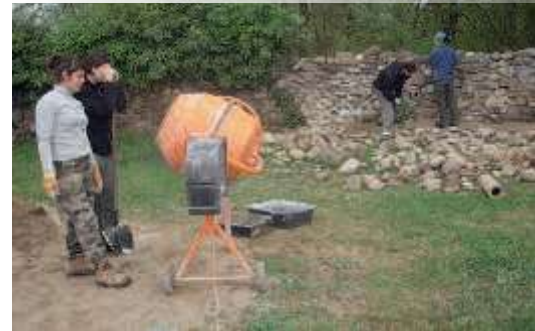
Chantier pédagogique de restauration d'un muret
