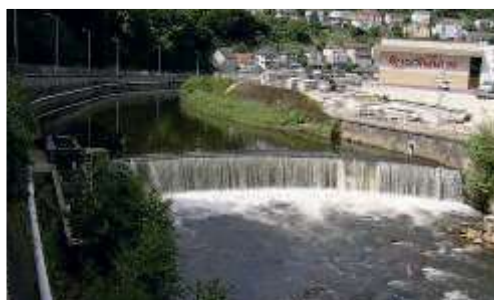
Suppression d'un seuil : avant et après
