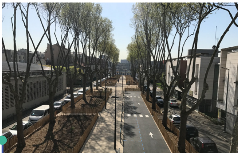
Pour gérer les eaux de pluie à la parcelle, la municipalité de Gennevilliers a créé de larges espaces plantés, vers lesquels ruissellent les eaux pluviales sur du béton désactivé. À gauche, la place Jaffeux, à droite, la place du Cadran Solaire.
